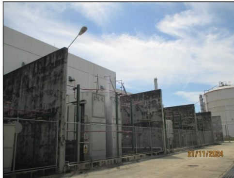
รูปที่ 3-21 พนักงานไฟระหว่างหม้อแปลงไฟฟ้าแต่ละชุด
