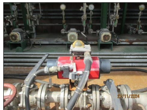
รูปที่ 3-35 Shut-off Valve บริเวณจุดเชื่อมต่อของถังเก็บ
