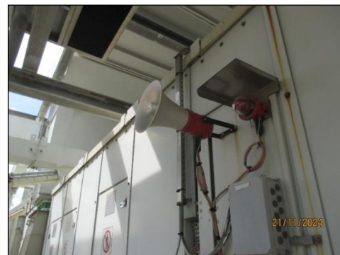
รูปที่ 3-26 Acoustic Alarm System
