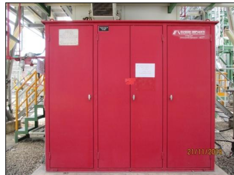
CO 2 Injection บริเวณ Gas Turbine Generator
