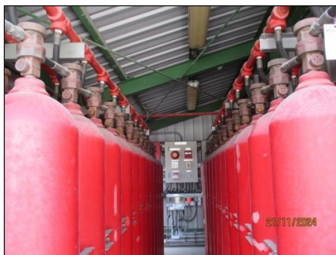
รูปที่ 3-40 Extinguisher Discharge System
