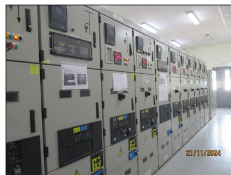
รูปที่ 3-19 ระบบ Remote Isolation
