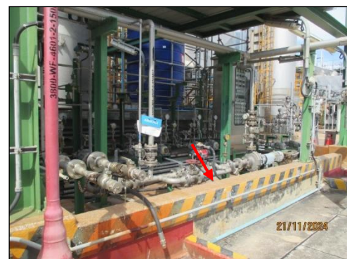
รูปที่ 3-7 เขื่อน (Bund) ล้อมรอบ บริเวณพื้นที่เก็บและสูบน้ำสารเคมี
