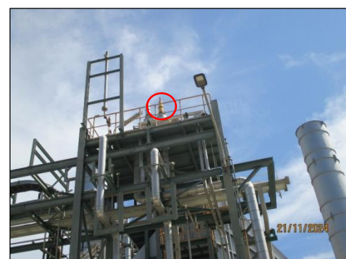
รูปที่ 3-43 Pressure Relief Valve
