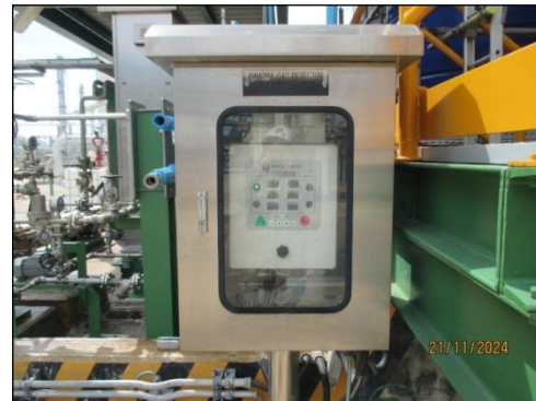
รูปที่ 3-33 เครื่องตรวจวัดการรั่วไหล (Ammonia Detector)
