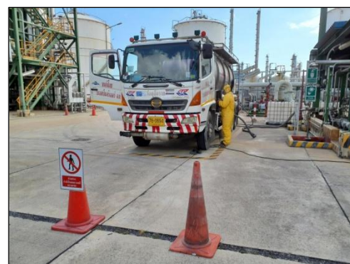
รูปที่ 3-41 การตั้ง Barricade ขณะทำการขนถ่ายสารเคมี
