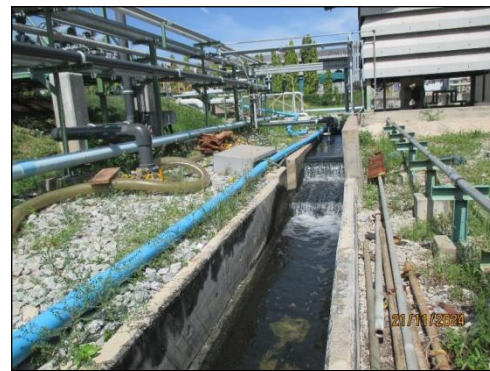
รูปที่ 3-17 จุดตรวจวัดอุณหภูมิน้ำทิ้ง ก่อนระบายลงสู่รางระบายน้ำทิ้งของนิคมฯ
