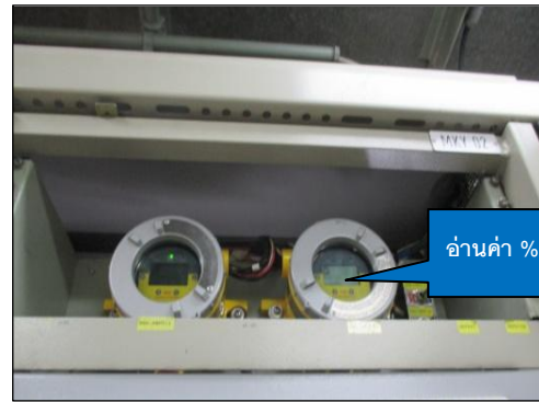
รูปที่ 3-45 Gas Detector Monitoring
