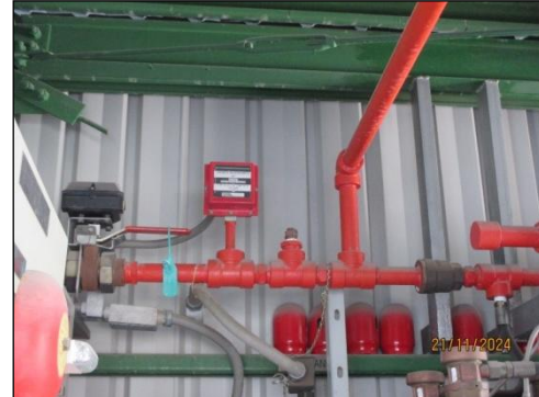
รูปที่ 3-39 Solenoid Valve CO 2
